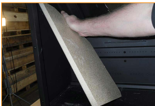
Venstre sideplate monteres
